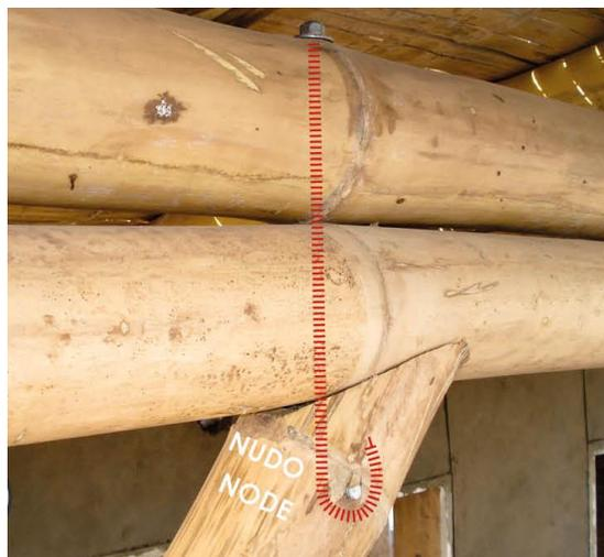
Figura 4: Conexión convencional con pico de flauta.
