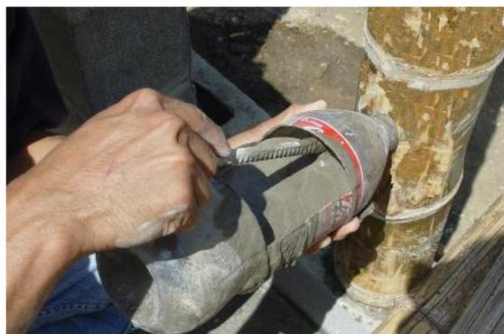
Figura 5: relleno de canutos con cemento. Del Manual de construcción "Construir con bambú" (Morán Ubidia, 2015)
